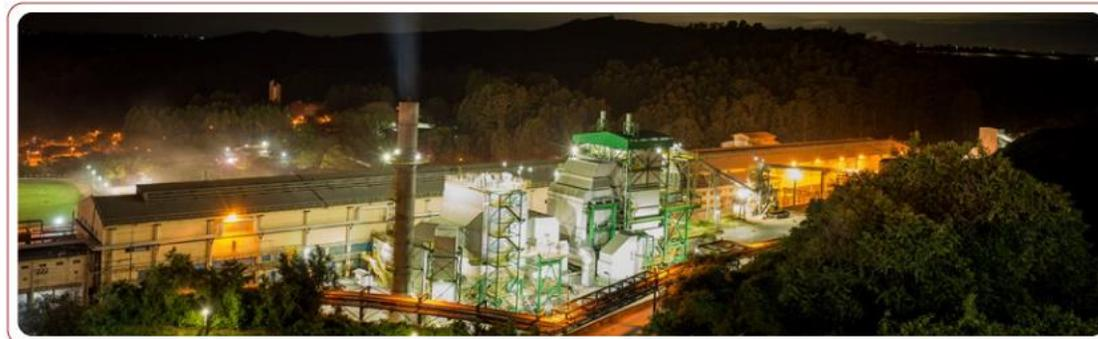
Apesar da complexidade operacional e de abastecimento da biomassa envolvida na produção de vapor, o processo de produção é composto por duas principais matérias-primas. Em um primeiro momento, há o tratamento químico da água antes de seu aquecimento. Depois, a partir da queima da biomassa, a água é transformada em vapor que, por sua vez, é distribuído aos clientes através de tubulações.
