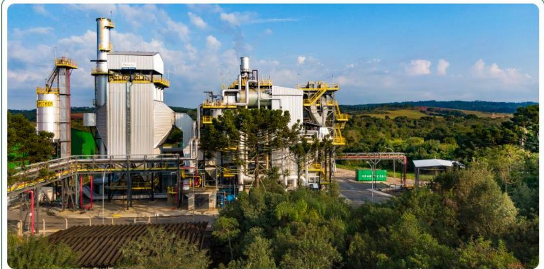
Após cerca de um mês, em setembro, a ComBio iniciou mais uma nova operação para seu cliente Ingredion, porém, agora, no município de **Balsa Nova (PR)**. Com uma unidade bastante similar à de Mogi Guaçu (SP), a companhia instalou duas caldeiras, cada uma delas com capacidade de produção de 50 toneladas de vapor por hora. A operação no estado do Paraná irá evitar mais de 91 mil toneladas de CO<sub>2</sub> na atmosfera por ano.
